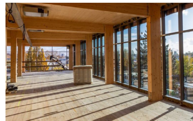
Figuur 5 | Glulam kolomstructuur en CLT vloeren
