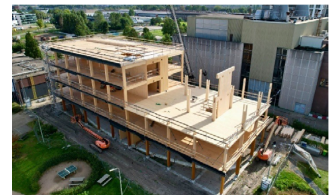
Figuur 3 | HoutWerk 2 in aanbouw
