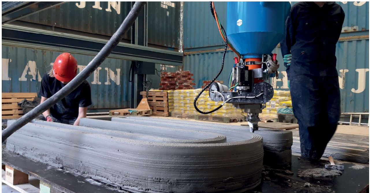
Voorafgaand aan de bouw van een woning met een 3D-printer worden eerst enkele vormen getest.
